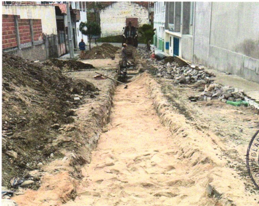
Foto 04 - ATERRO MANUAL COM SOLO ARGILLO-ARENOSO IMPORTADO E COMPACTAÇÃO MECANIZADA EM CAMADAS DE 0,20 M NO MÁXIMO
