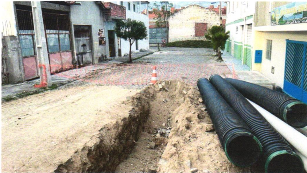
Foto 03 - ESCAVAÇÃO DE VALA
