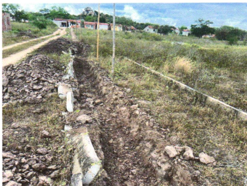
Foto 02 – ESCAVAÇÃO DE VALA
